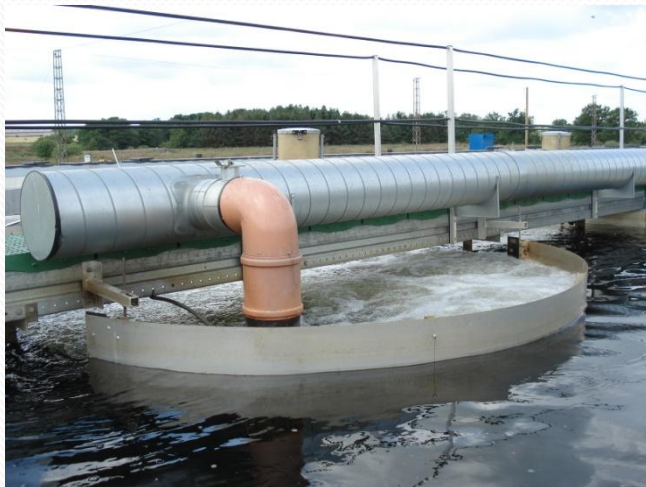
Lavtryksbeluftning 75 cm dybde
